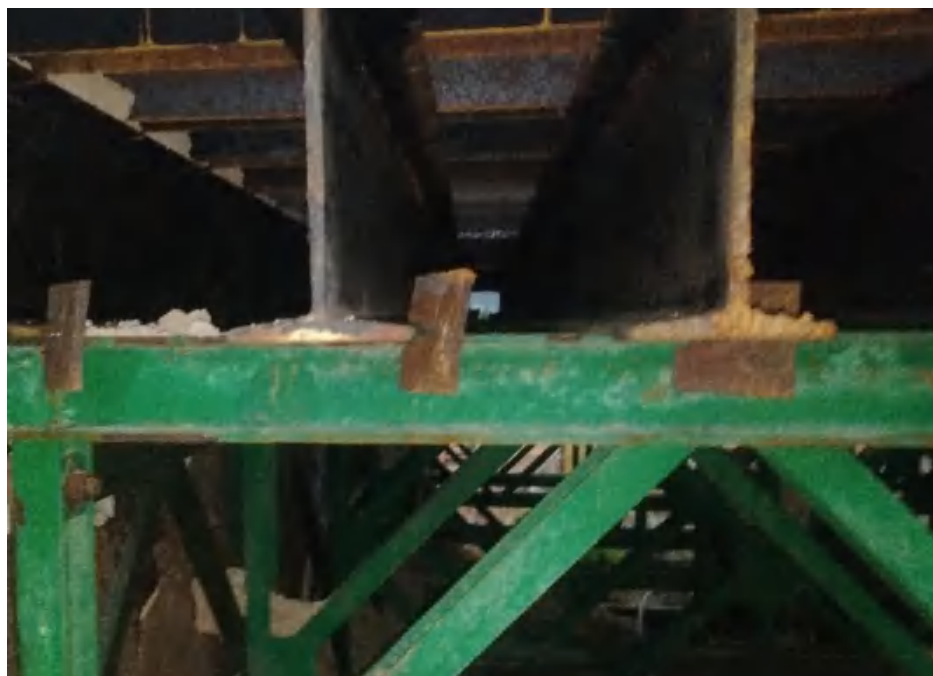
图 3.15-19 分配梁安装示意图
