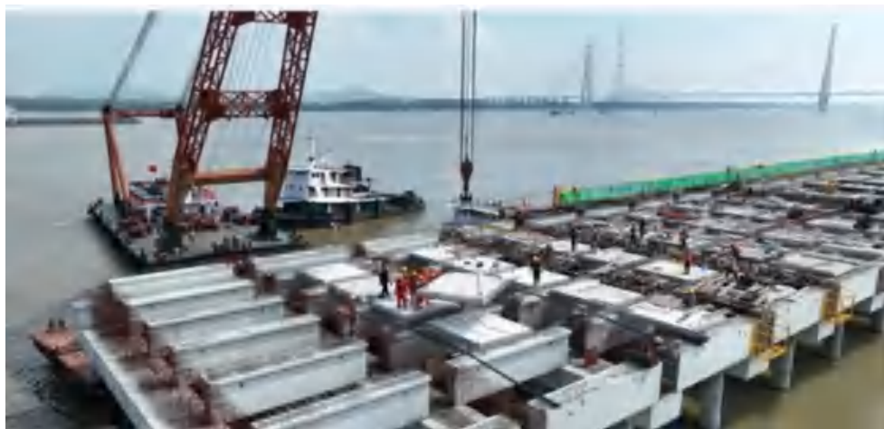
图 3.15-33 预制构件安装示意图
