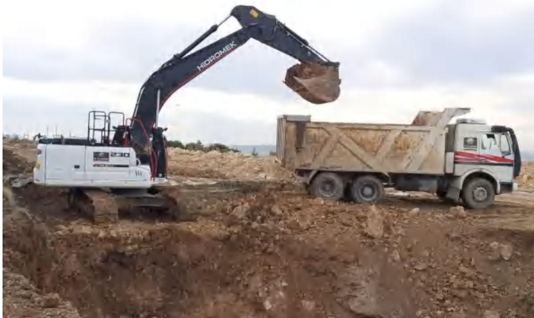
图 3.15-4 陆域开挖示意图
