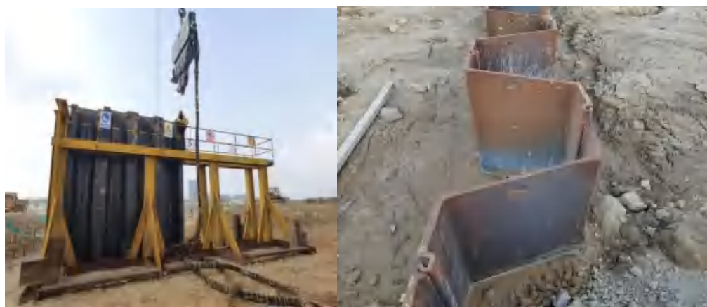
图 3.15-28 导向架插桩沉桩示意图
