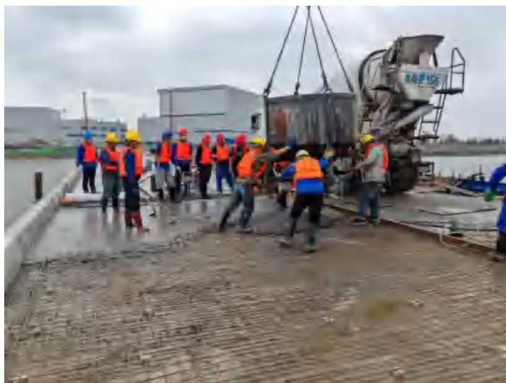
图 3.15-36 现浇面层示意图
