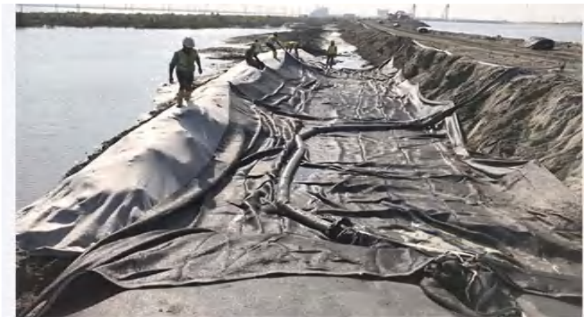
图 3.15-5 围堰建设示意图
