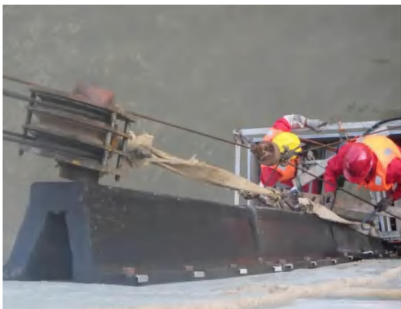
图 3.15-37 橡胶护舷安装示意图
