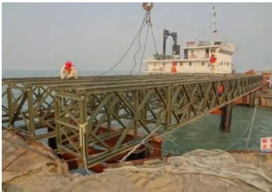
图 3.15-18 贝雷架搭设示意图
