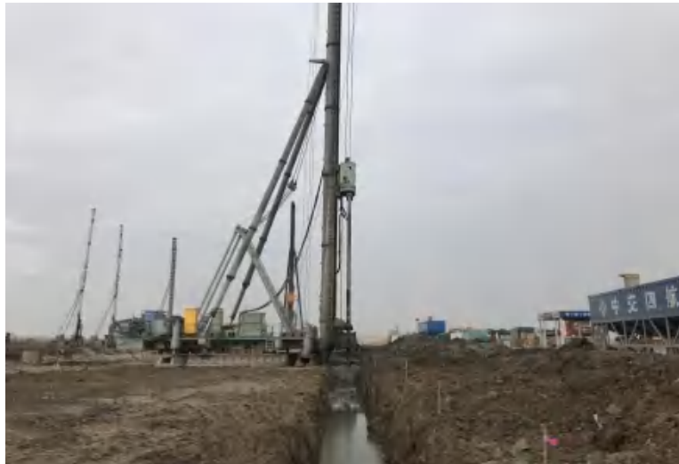
图 3.15-31 三轴搅拌桩施工示意图
