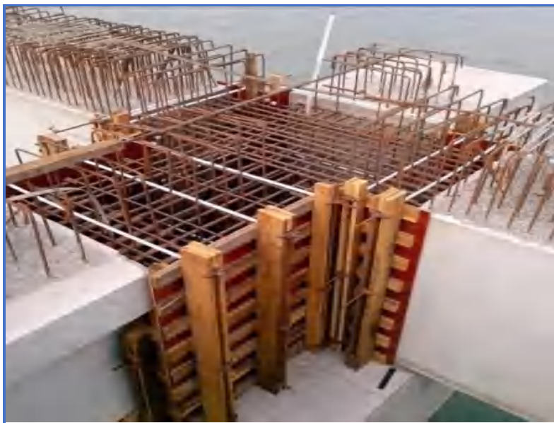
图 3.15-35 现浇梁节点示意图
