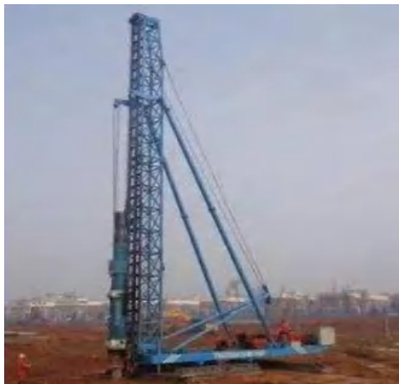
图 3.15-26 钢管桩施工示意图
