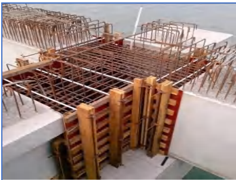
图 3.13-33 现浇梁节点示意图
