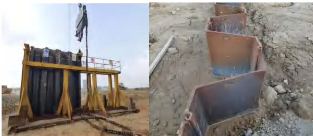
图 3.13-26 导向架插桩沉桩示意图
