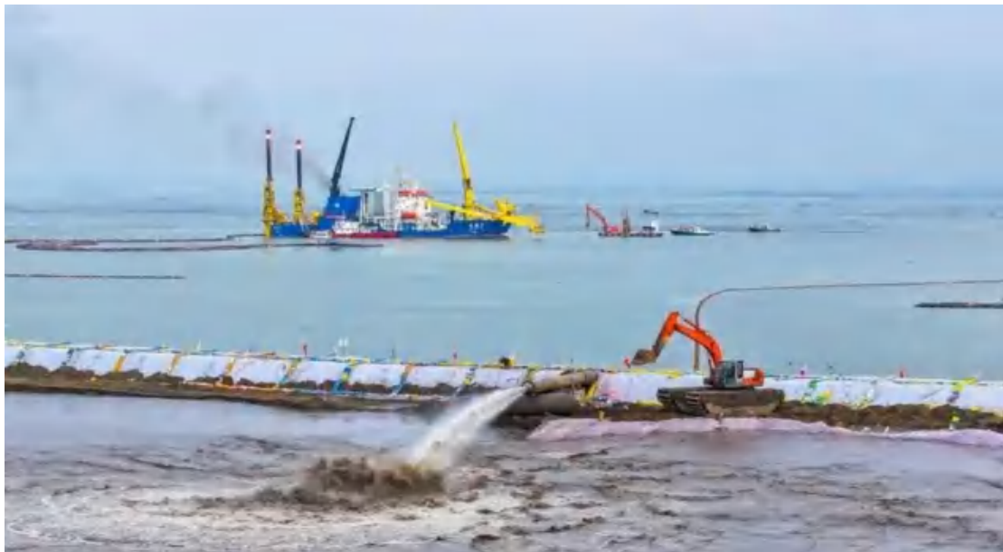
图 3.13-7 绞吸船吹填水工示意图
