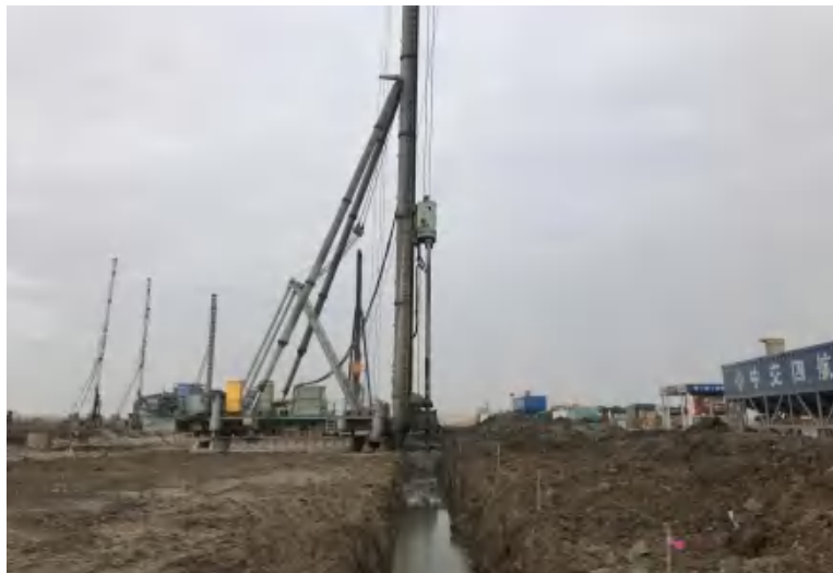
图 3.13-29 三轴搅拌桩施工示意图
