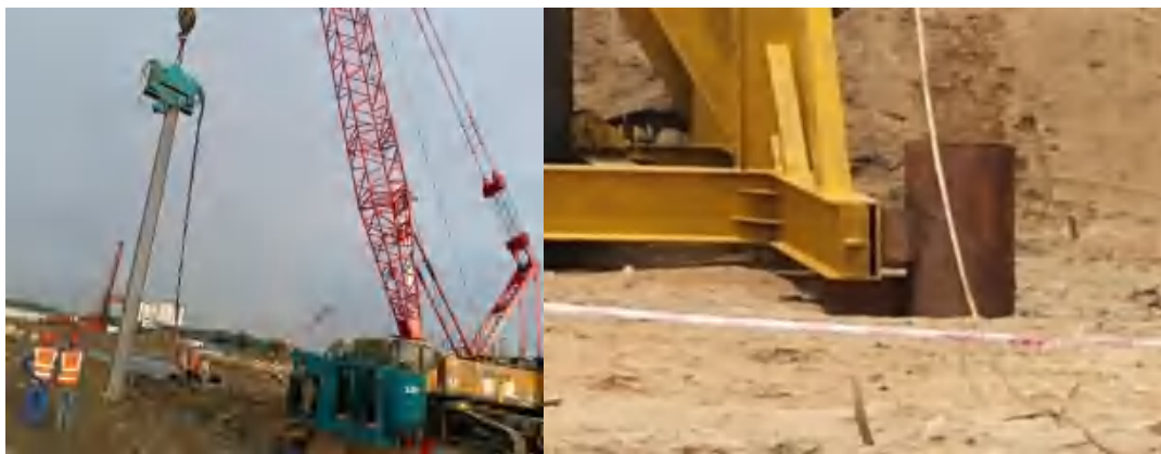
图 3.13-25 导向架安装示意图
