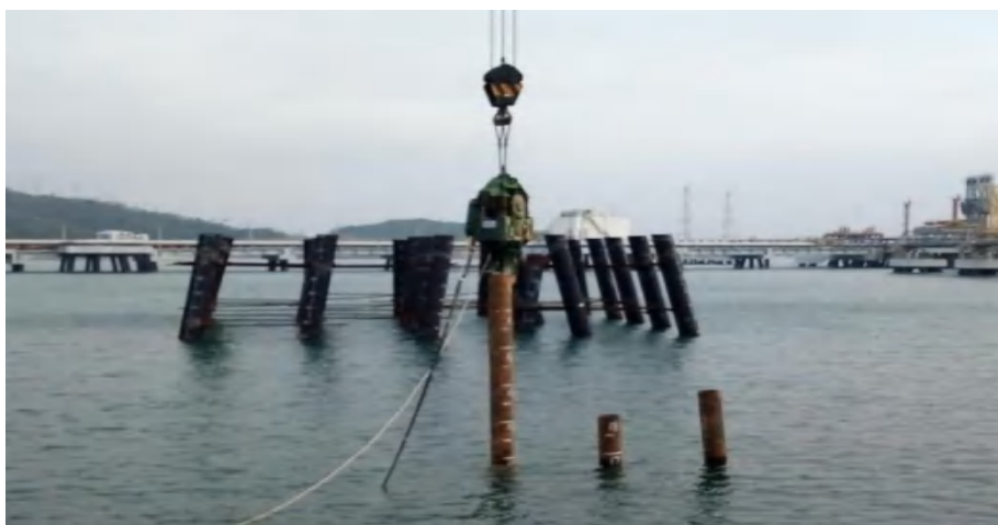
图 3.13-13 辅助桩施打示意图
