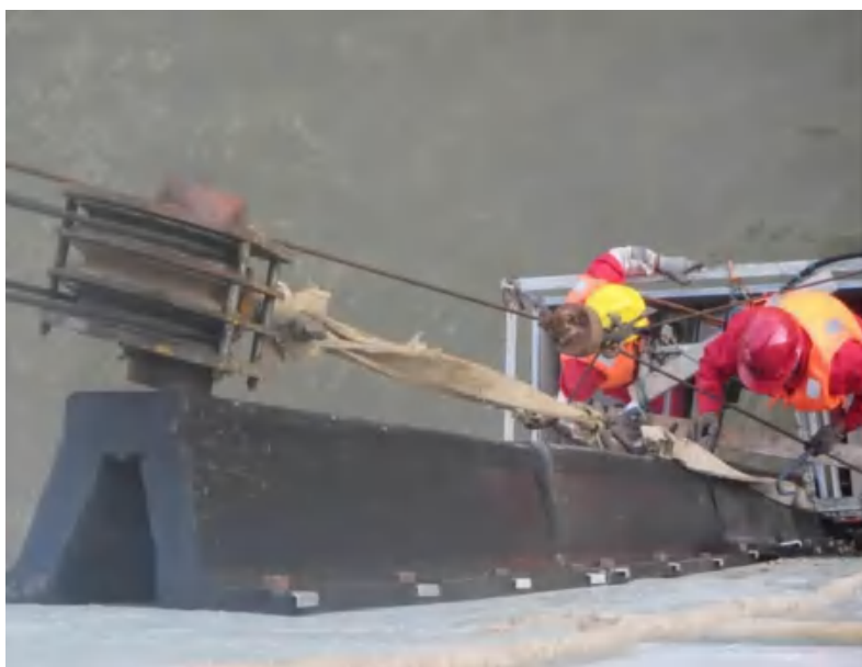
图 3.13-35 橡胶护舷安装示意图
