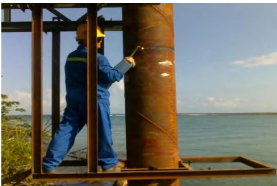
图 3.13-14 标注桩头切割线
