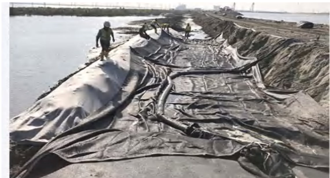
图 3.13-5 围堰建设示意图
