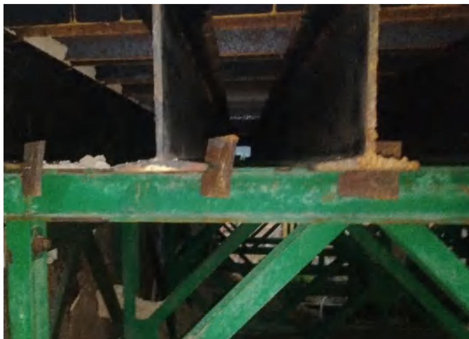
图 3.13-17 分配梁安装示意图
